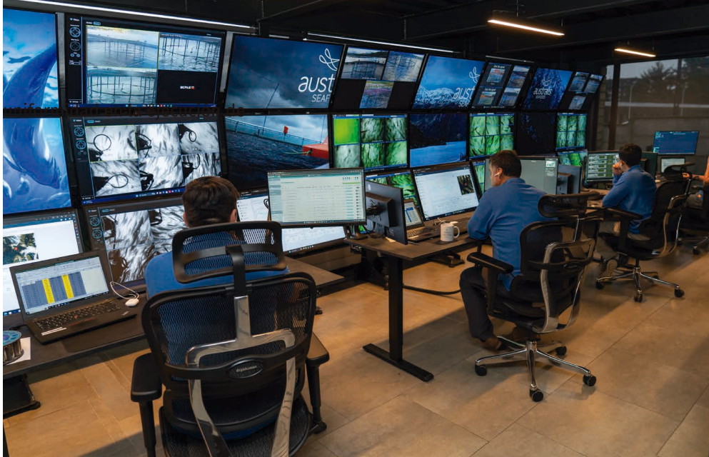
Sala de Alimentación Remota de Australis. Fotografía: cedida
