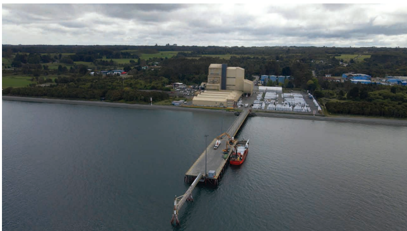
Planta de alimento en Chile. Fotografía: Skretting Chile
