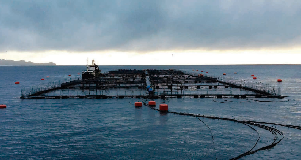
Centro de Agua Mar Punta Islotes. Fotografía: Salmones Camanchaca
