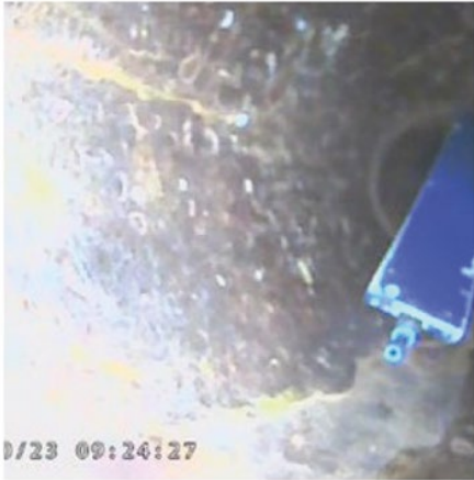
Figura 8. Tubería de descarga Barco.
